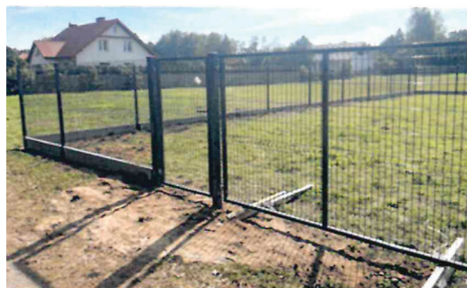
Zagospodarowanie działki gminnej - montaż ogrodzenia w Józefowie
