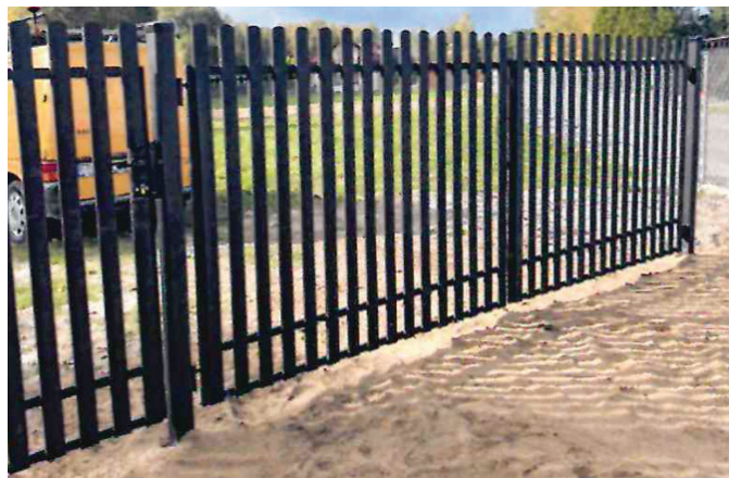
Zagospodarowanie działki gminnej - montaż ogrodzenia w Adamowie
